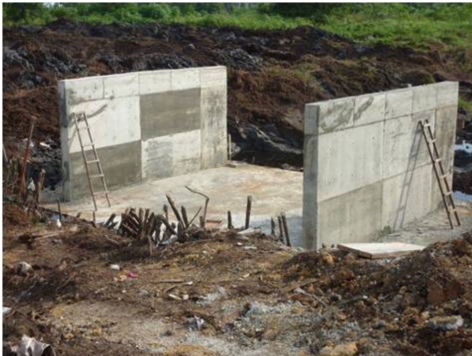
Fig. 5.3 – Pembinaan 'Check Dam' di kawasan tanah lembut menggunakan ERP System sebagai asas struktur.
