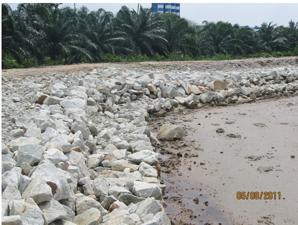
Fig. 5.11 – Lapis lindung batu yang telah siap dibina menggunakan ERP System (ketika air surut)
