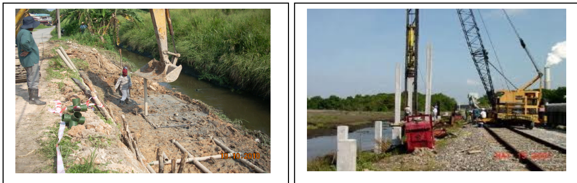
Fig. 6.2.1 – Perbandingan kaedah pemasangan ERP System (kiri) dan cerucuk konkrit (kanan) bagi asas struktur
