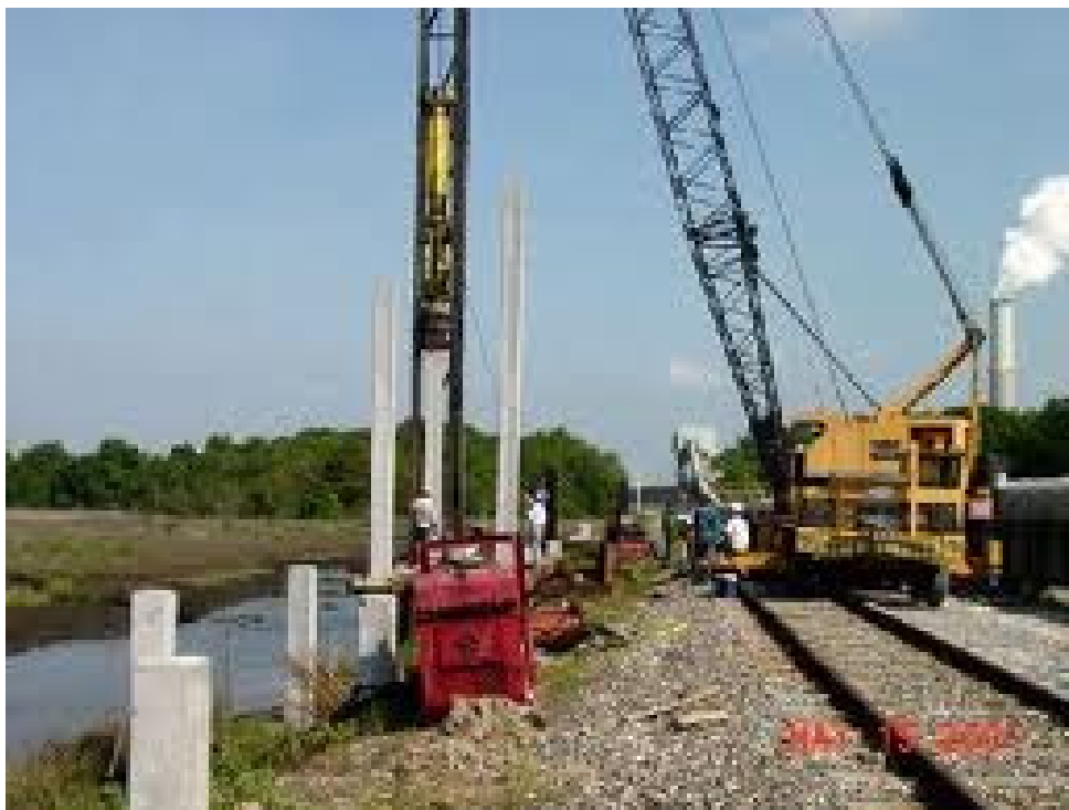
Fig. 2.4 – Pemasangan cerucuk konrit menggunakan mesin khas
