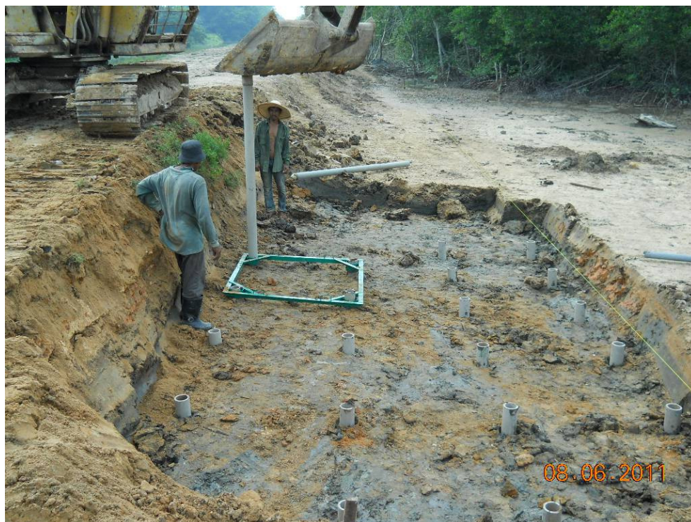
Fig. 5.5 – Kerja-kerja pemasangan cerucuk ERP System .
