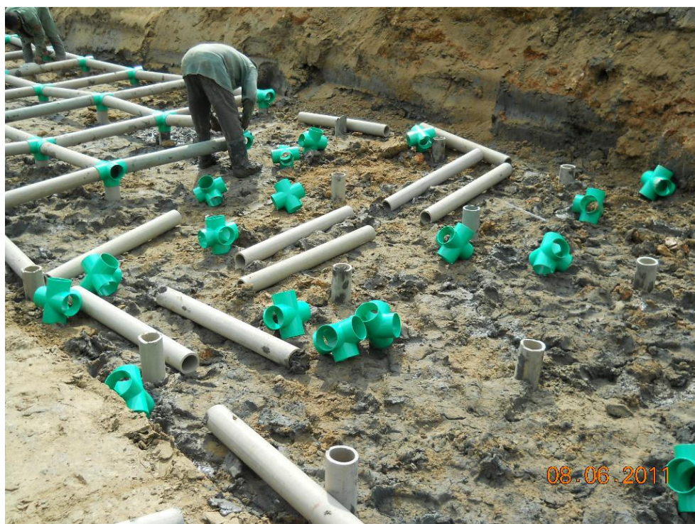
Fig. 5.7 – Pemasangan ERP System dengan grid 1m x 1m di tapak.
