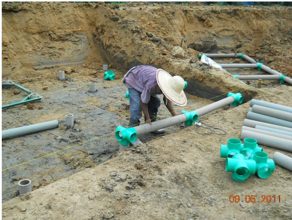
Fig. 5.6 – Pemasangan elemen rakit kepada cerucuk menggunakan penyambung khas (ERP connectors).
