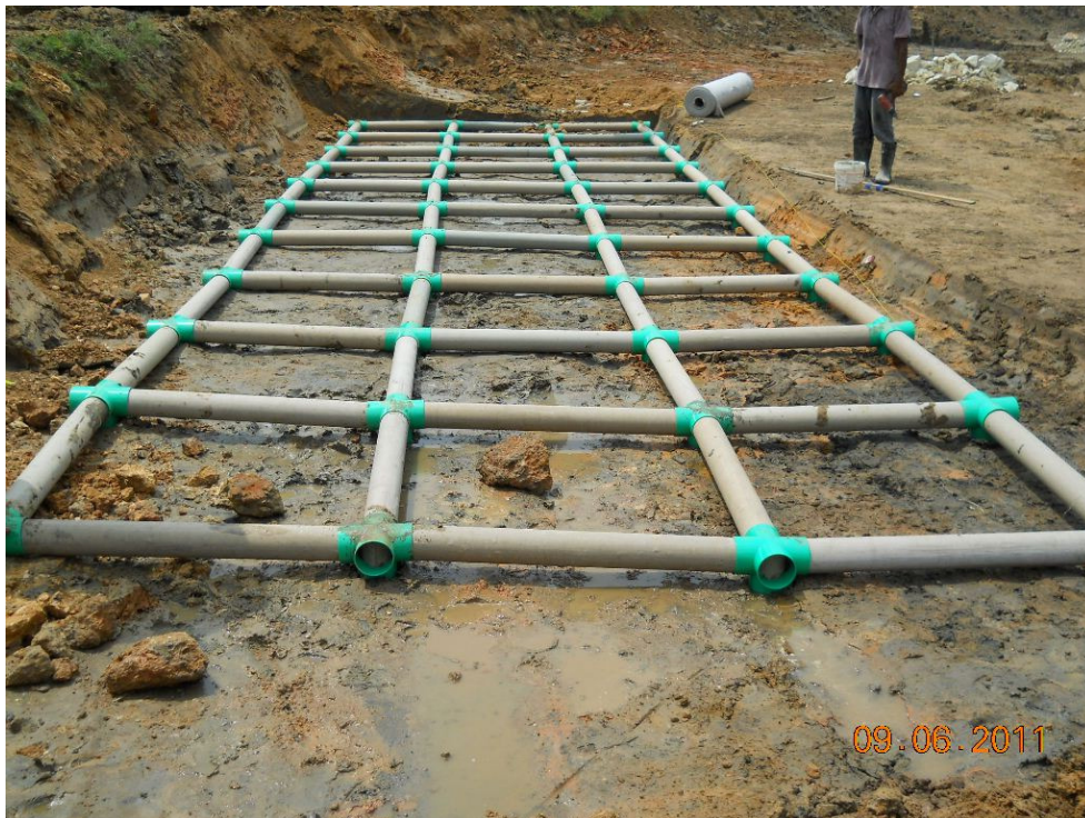
Fig. 5.8 – Keadaan ERP System yang telah siap dipasang di tapak.
