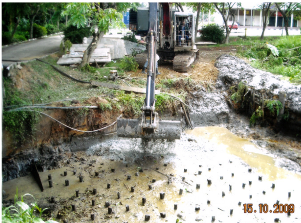
Fig. 2.1 – Cerucuk bakau bagi kerja-kerja pembinaan di tanah lembut
