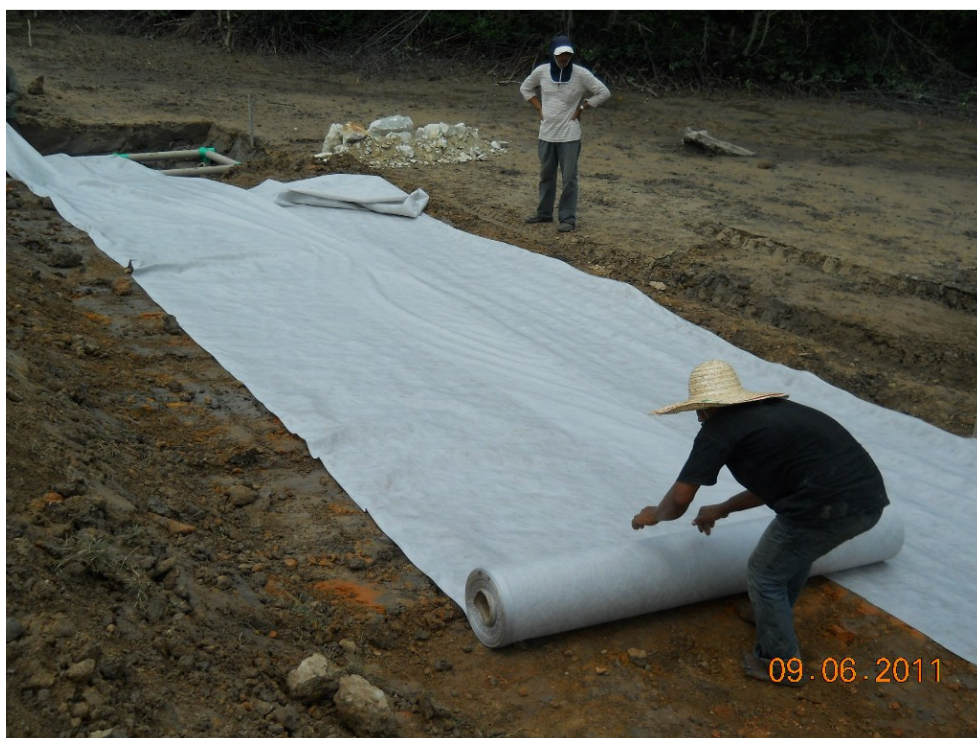
Fig. 5.9 – Kerja-kerja pemasangan geotextile.
