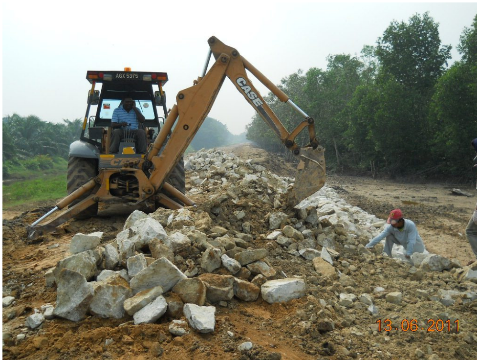
Fig. 5.10 – Kerja-kerja pembinaan lapis lindung batu (rock revetment).
