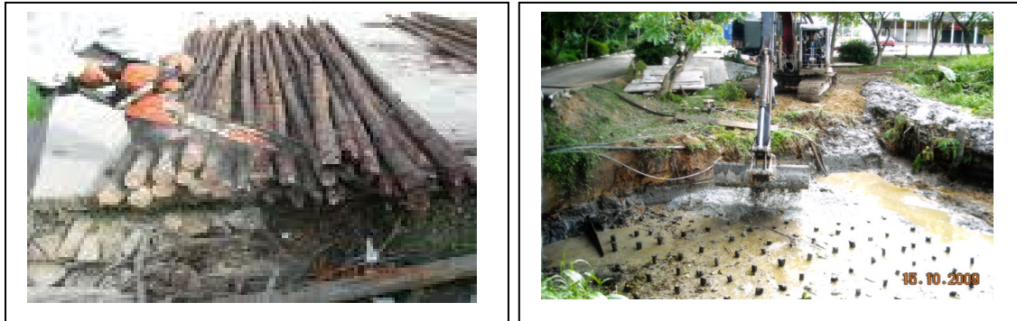
Fig. 6.2.2 – Keadaan kayu bakau di tapak (kiri) dan kaedah penanaman cerucuk bakau bagi asas struktur yang memerlukan kuantiti yang tinggi (kanan).
